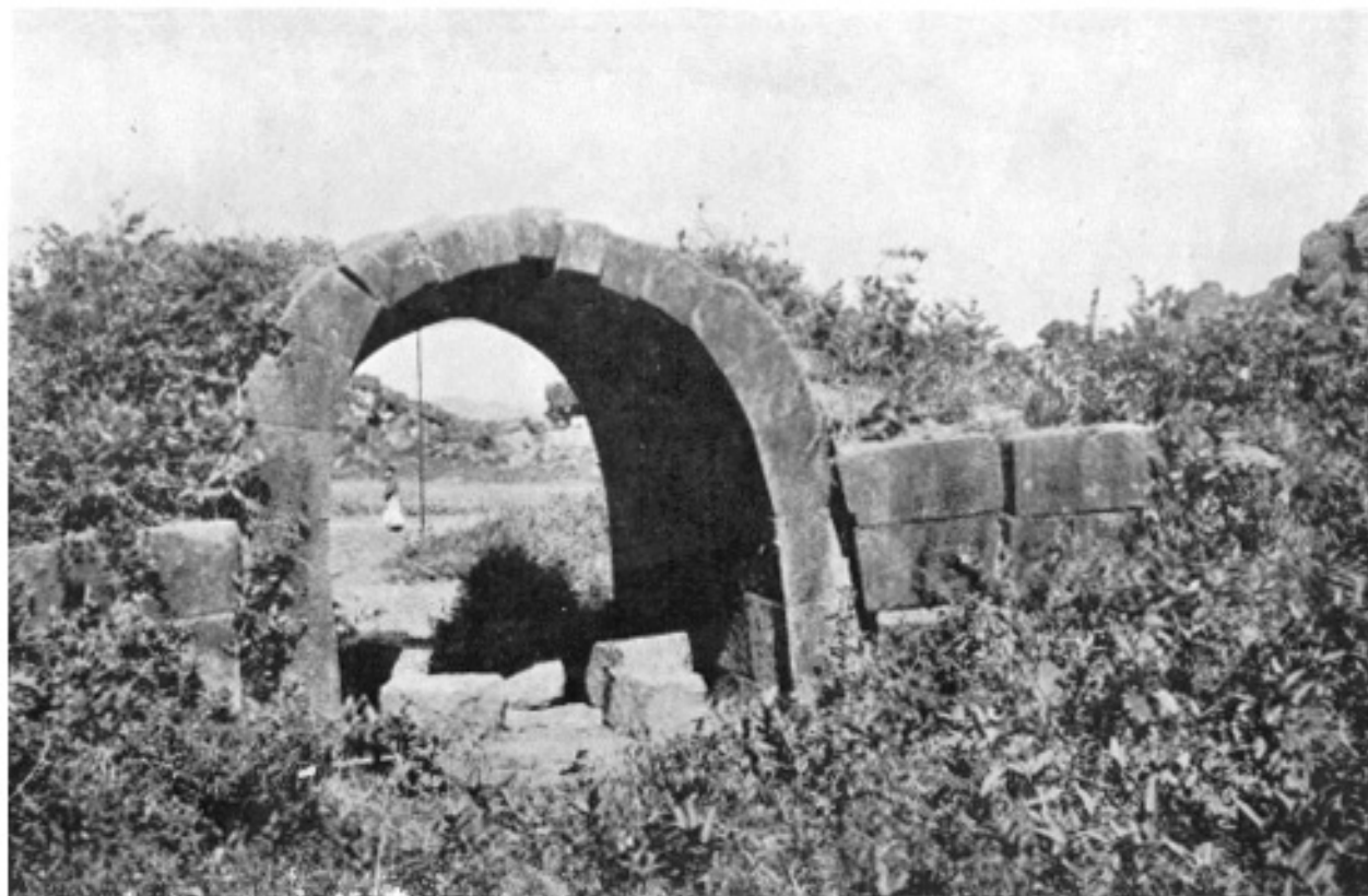
Planche LXVI. — Porte du camp retranché des carriers lors de la construction de la citadelle des Hố (Thanh - Hóa ). ( Clichés L. Bezacier ).
